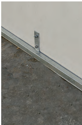
Der Verstärkungsrahmen verleiht der Hütte zusätzliche Stabilität
